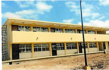
F1: Edificio B
