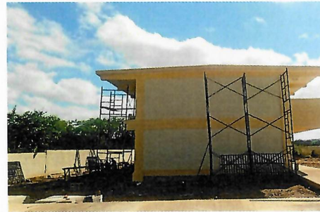
F2: Edificio B y Cerca Perimetral
